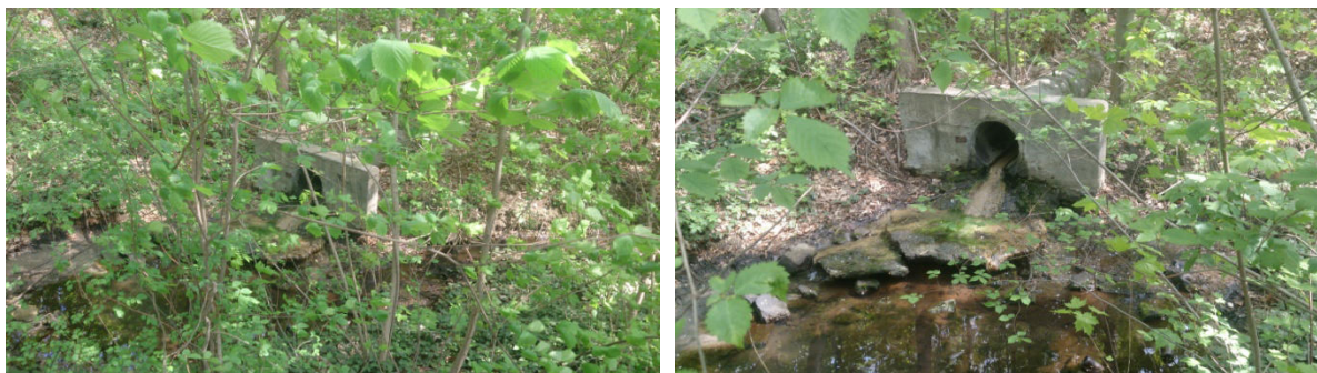
Widok na umocniony wylot kanalizacji deszczowej do rowu - potoku.
