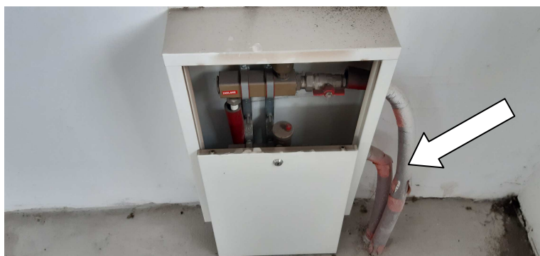
fot. nr 5 - piony CO przewidziane do zabudowy na kondygnacji II piętra (przykładowa lokalizacja)
