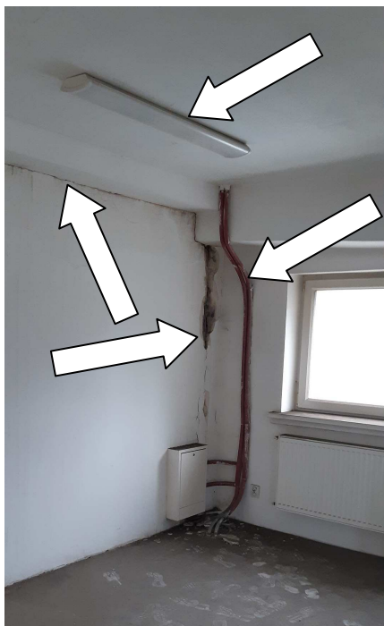
fot. nr 6 - przykładowe miejsce do naprawy tynku, pion do zabudowy, oprawa oświetleniowa do demontażu i wymiany na nową;
