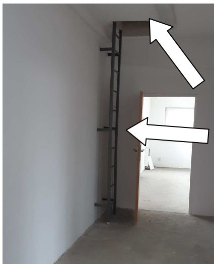
fot. nr 1 - drabina do rozbiórki, otwór w stropie do zabudowy
